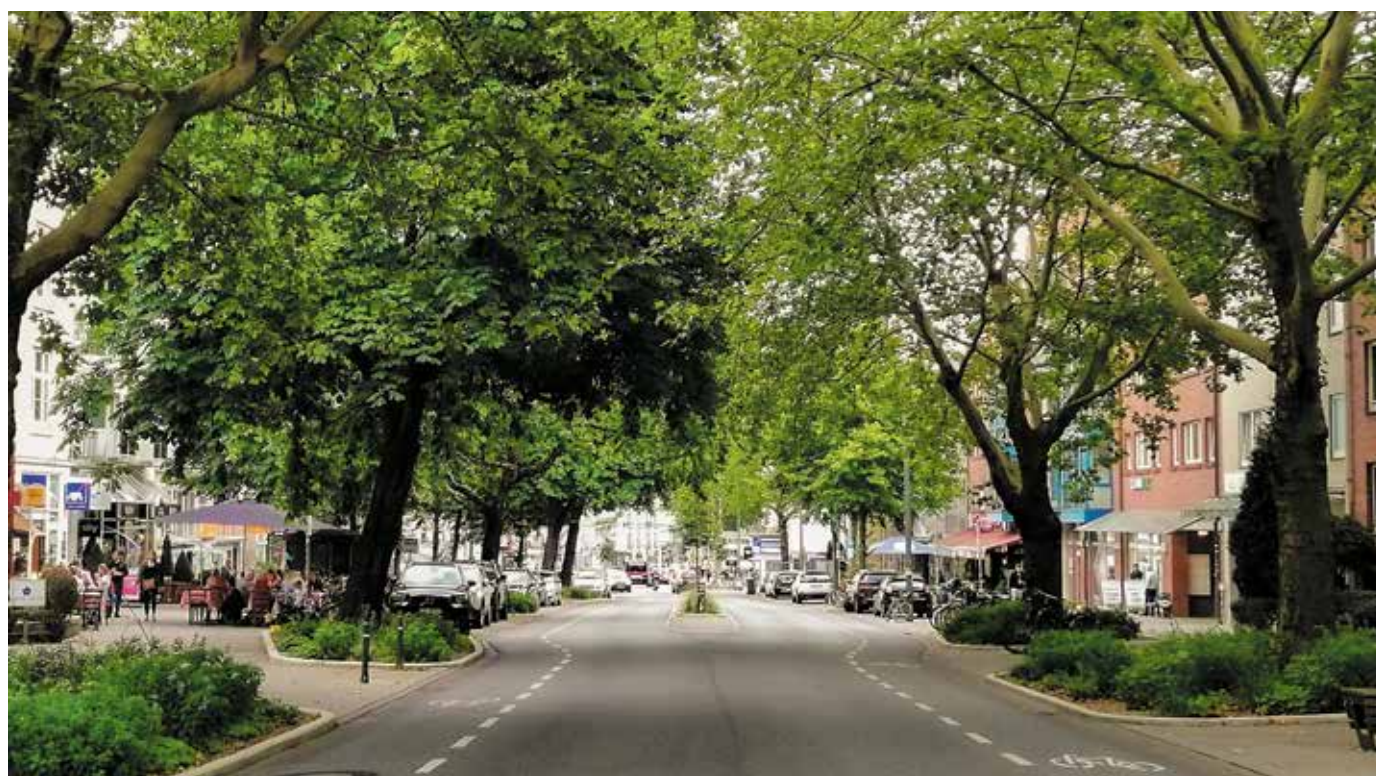
Zweispurig ausgebaute Hauptverkehrsader Osterstraße: Raumbreite ca. 33 Meter, 2 Kfz.-Spuren abwechselnd mit/ohne Mittelgrün, begrünte Bauminseln, belebte Gehwege. Verkehrsbelastung: Frequenz bis zu 13.000 Kfz. pro Tag.
